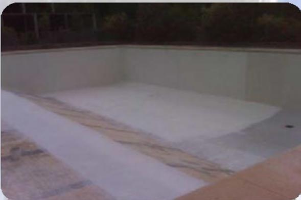
El recubrimiento aplicado, asegura una estanqueidad completa en la piscina. La colocación de la resina de poliéster reforzada con fibra de vidrio nos garantiza una lamina impermeable que evita estas fugas y pueden absorber los movimientos que puedan aparecer en el futuro. En este proceso se aplican resinas de gran calidad que nos garantizan una larga vida del recubrimiento, así como grandes pinturas acordes con los materiales empleados.
